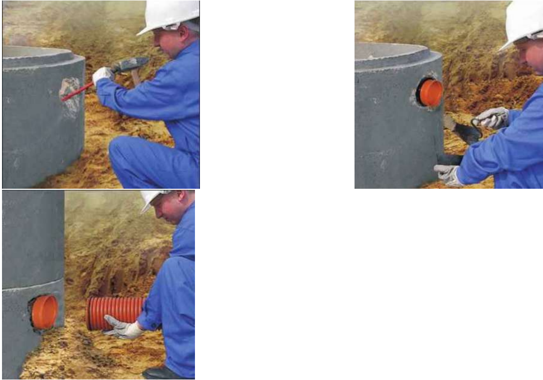
Slika 7: Spajanje PP cijevi na betonski šaht
